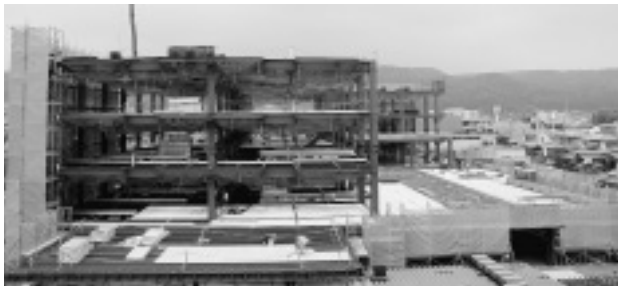
鉄骨工事の様子
