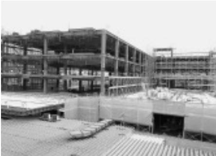
鉄骨工事を終えた様子
