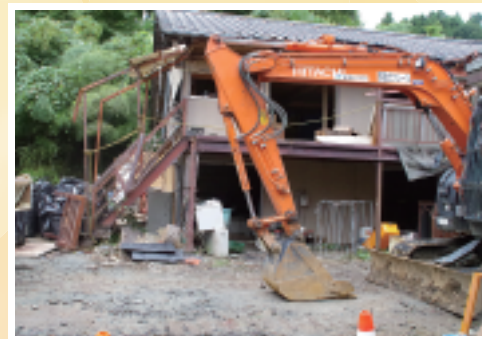
▲ 取り壊しが進むようす
