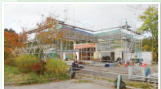
帰還困難地域の復興拠点で進む家屋解体
